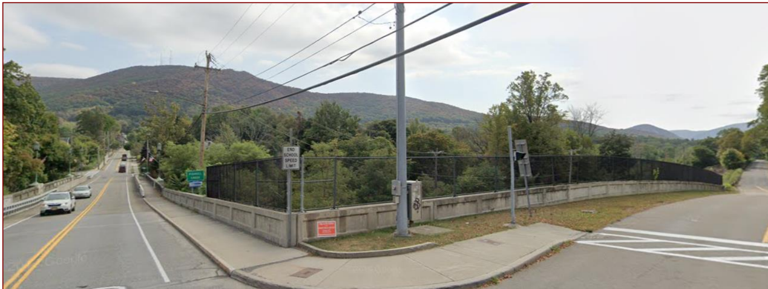
Route 9D and Tioronda Avenue
