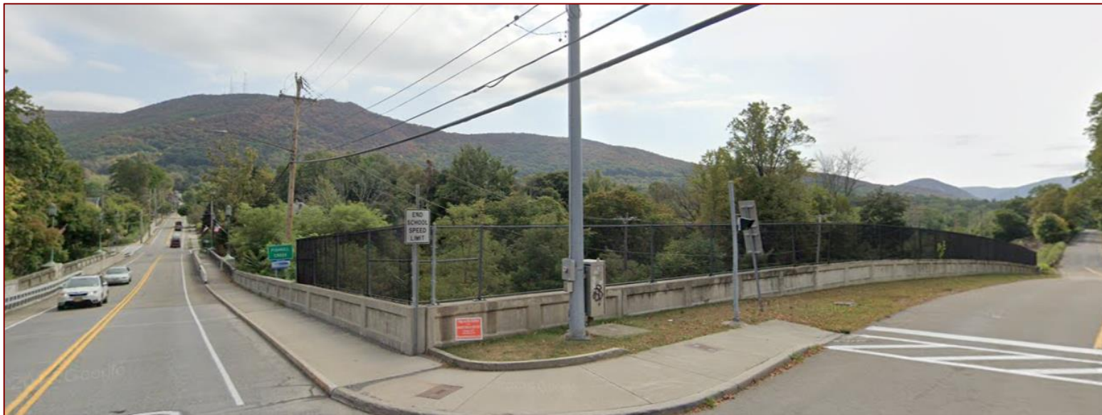
Route 9D and Tioronda Avenue
