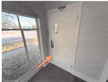
Right side exterior door
