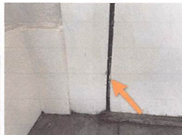
Right side exterior door
