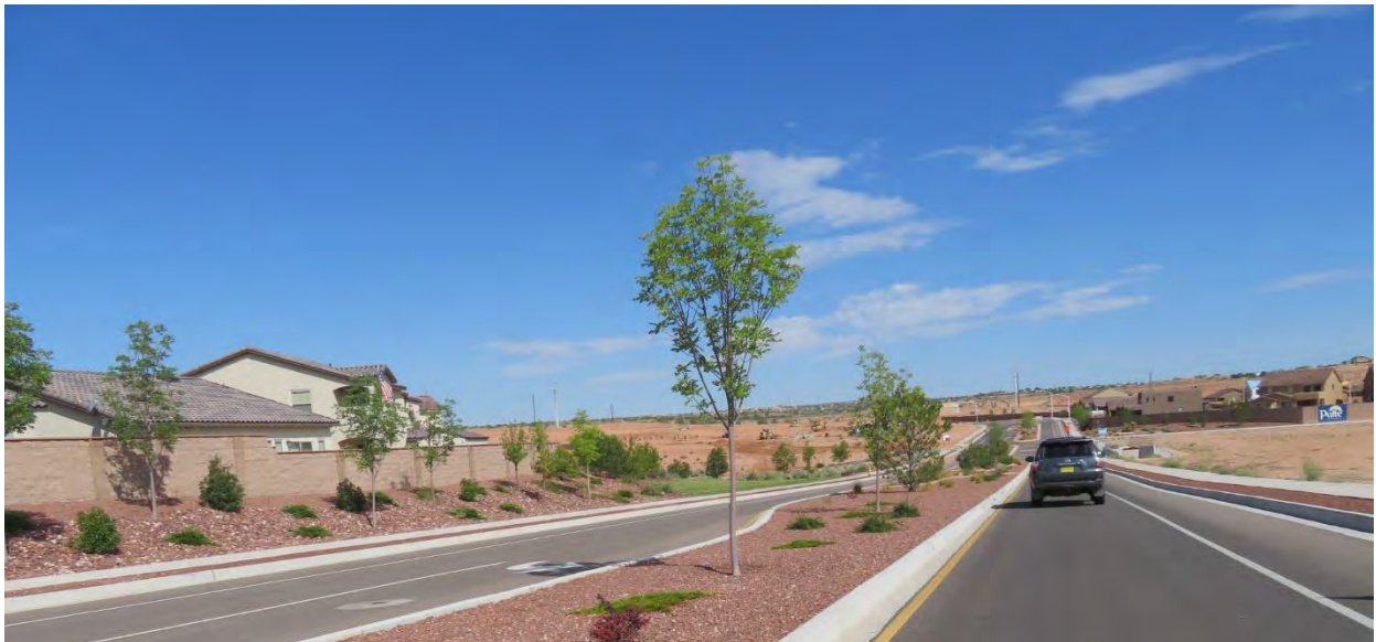
Camino Encantadas Roadway Heading North
