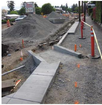
MOD. GRAVEL LAYER
