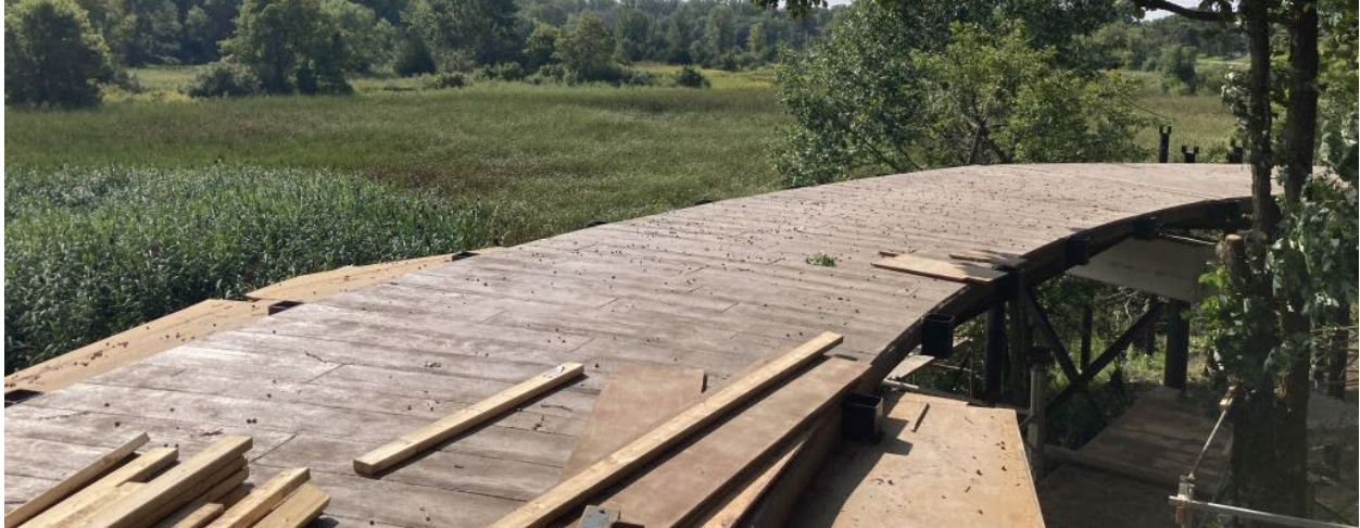
Treetop Trail – First concrete pour complete.
