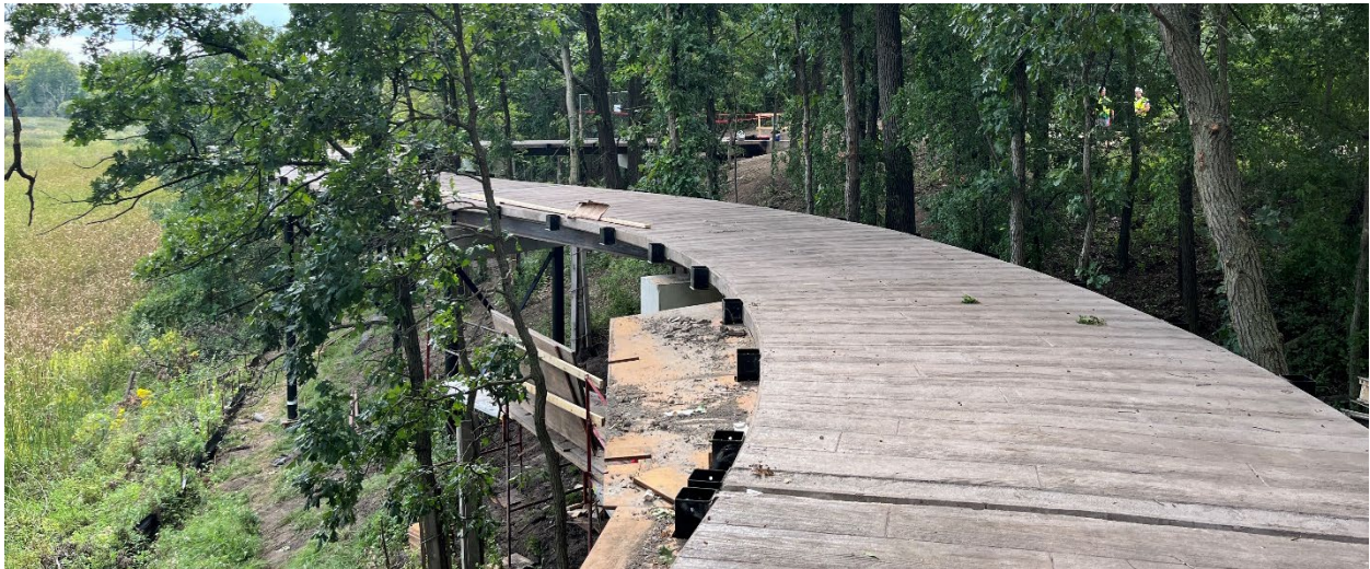
Treetop Trail – Second concrete pour complete.
